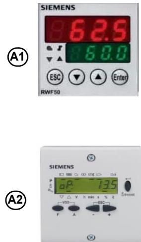
Fig. 11 - Pannello frontale quadro elettrico bruciatore
